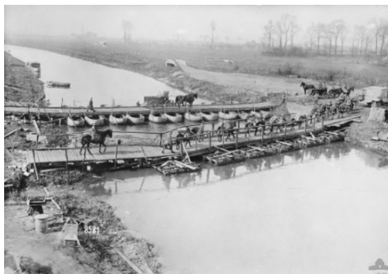
Avril 1918. Pont provisoire bâti par les ingénieurs allemands, probablement au dessus de la Lys sur la route de Nieppe à Armentières.
