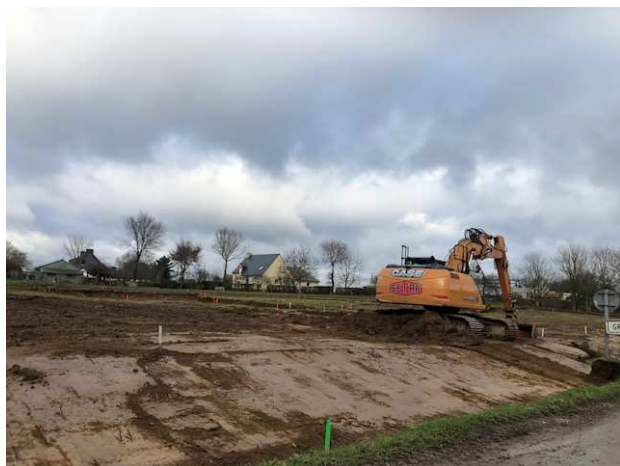
Terrassement du clos Rémi et début des travaux d'effacement des réseaux.
