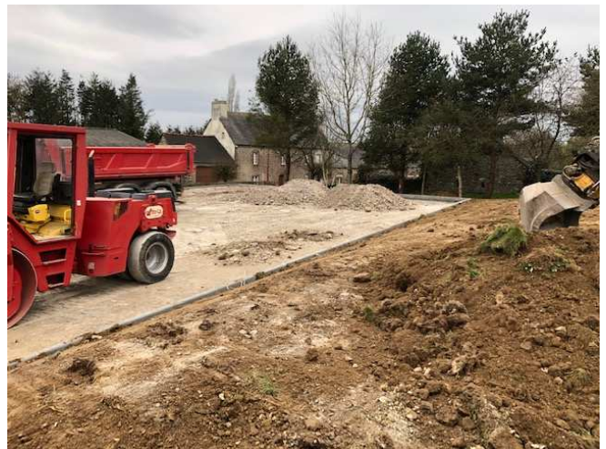
Terrassement du multisports.
